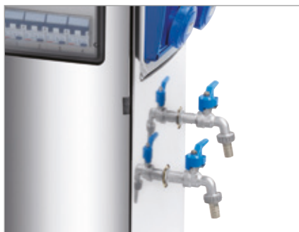
Weerskit gescheiden door de energietoevoer
