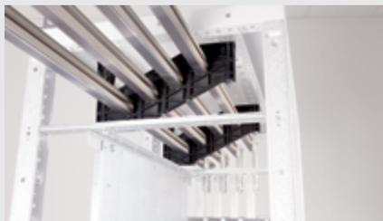
Rápido, económico y versátil, el sistema universal de barras de aluminio permite personalizar al máximo los cuadros de distribución GEWISS, gracias a las diferentes configuraciones de posicionamiento.
