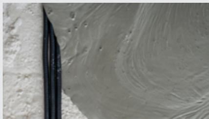
Los tubos FK-Xtreme, gracias a su diseño especial de doble pared, garantizan una protección total frente a la penetración de cemento líquido auto nivelante. El revestimiento exterior ofrece una resistencia adicional en la obra frente el pisoteo, el aplastamiento y los impactos, incluso a bajas temperaturas (hasta -25 °C).
