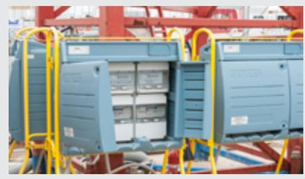
Los paneles adicionales específicos permiten crear distintas configuraciones de cuadros de distribución, según las necesidades específicas de cada obra. Gracias a los paneles de cuadros, por ejemplo, es posible obtener cuadros de sólo interruptores (hasta 60 módulos), mientras que con los paneles de bases de tomas es posible cuadros con 12 bases de tomas enclavadas.
