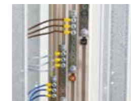
Barretta connessione interruttori modulari
